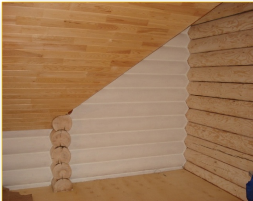
Утепление деревянных стен
